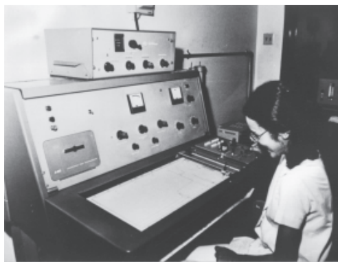
RESSONÂNCIA MAGNÉTICA NUCLEAR VARIAN A- 60 Um dos primeiros aparelhos de RMN adquiridos no Brasil (Projeto Xistoquímica)
